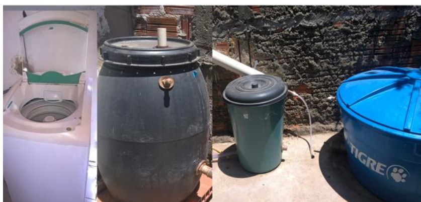
Figura 4: sistema de reaproveitamento de água da máquina de lavar. Fonte: Aluno
